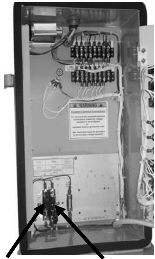
Figura 10. Interruptor de cortocircuito del TC y desconexión del TP.
